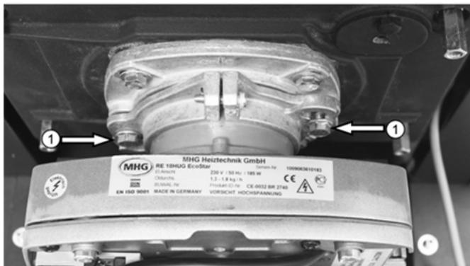
Abb. 20: Brennerbefestigungsschrauben ①
