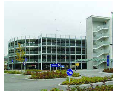
LORO-X Parkhaus- Entwässerung
