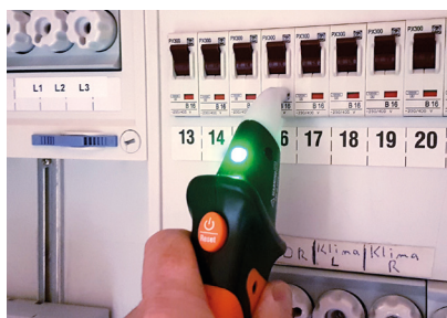
Grüne LED: Sicherung gehört zum gesuchten Stromkreis.
