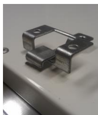
Detail eingehängte Deckenhalter
