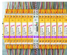
2x 165 Klebeetiketten zum Kennzeichnen der Busadresse für Überwachungsgeräte DRC MCM XT (BA1 bis BA15) und der laufenden Nummer für die zugeordneten BXT-Basisteile oder -Module, (1.1-1.10 bis 15.1-15.10).
